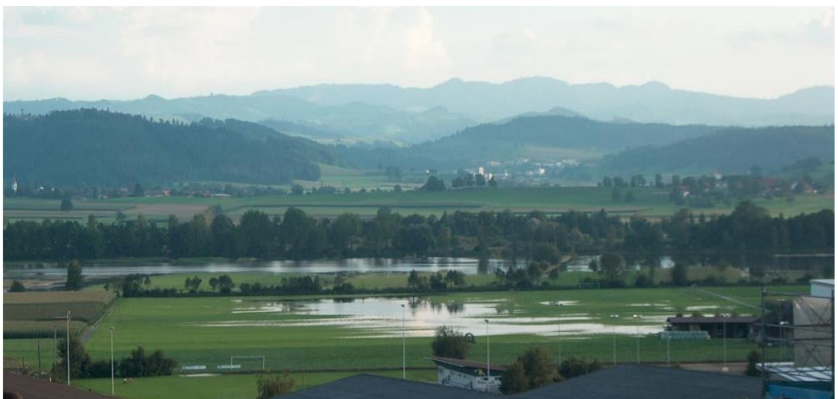
Abbildung 2: Weiträumige Überflutungen bei einem Dammriss
