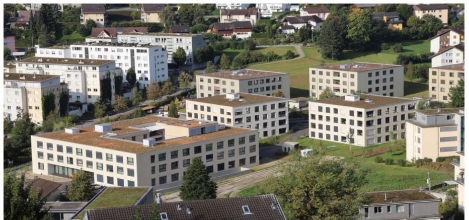
Links das Pflegezentrum, dahinter die beiden Wohngebäude (vordere Reihe).
